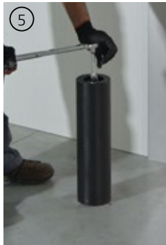
Fijación bolardo Bollard fixing
