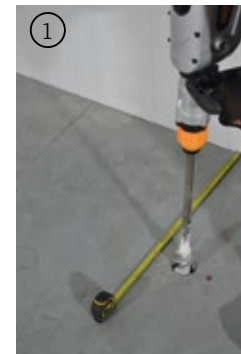
① Medición y perforado Measuring and drilling
