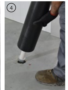
④ Colocación bolardo Bollard placement
